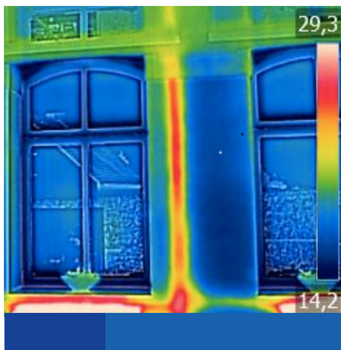
Rys. 3. Zastosowanie kamery termowizyjnej do wykrycia przebiegu zabudowanej instalacji centralnego ogrzewania.
