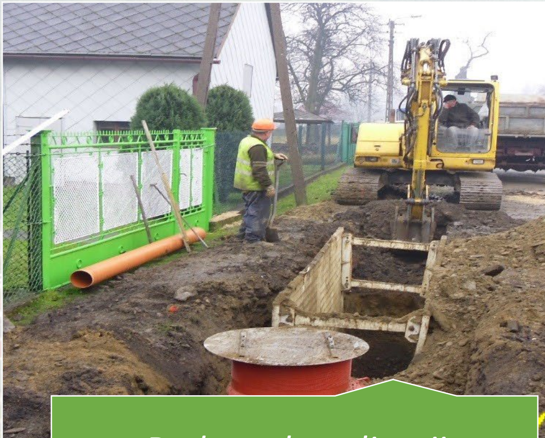
Budowa kanalizacji sanitarnej w Kalnej
